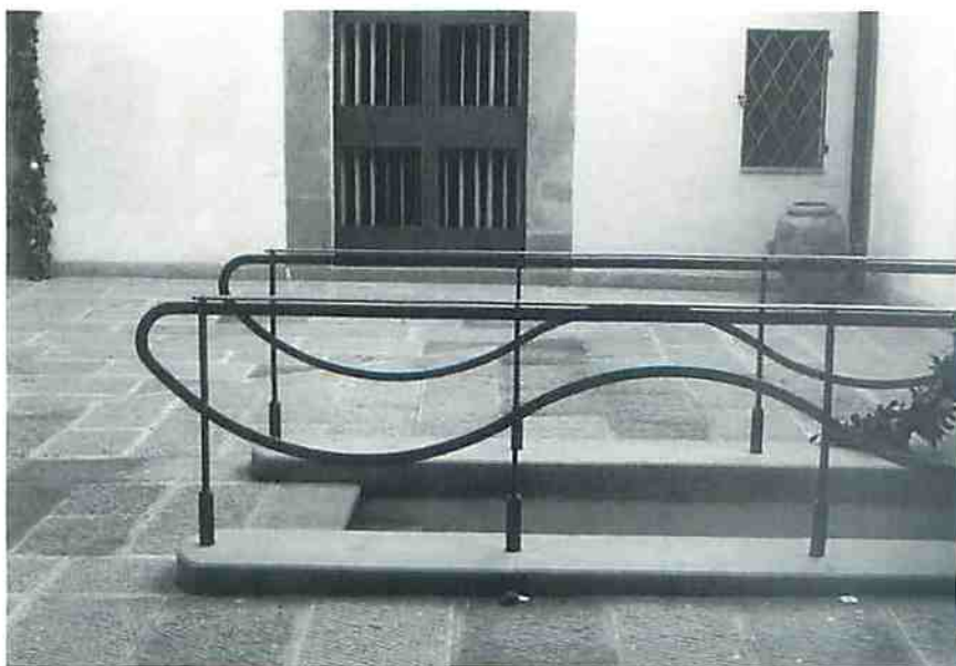
Un altro particolare 'attuale': la ringhiera dell'accesso all'interrato.
