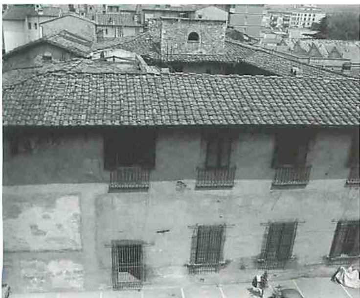
Lo stato di conservazione delle coperture prima del restauro.
