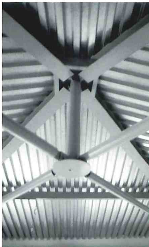
Intervento nella parte moderna: copertura.
