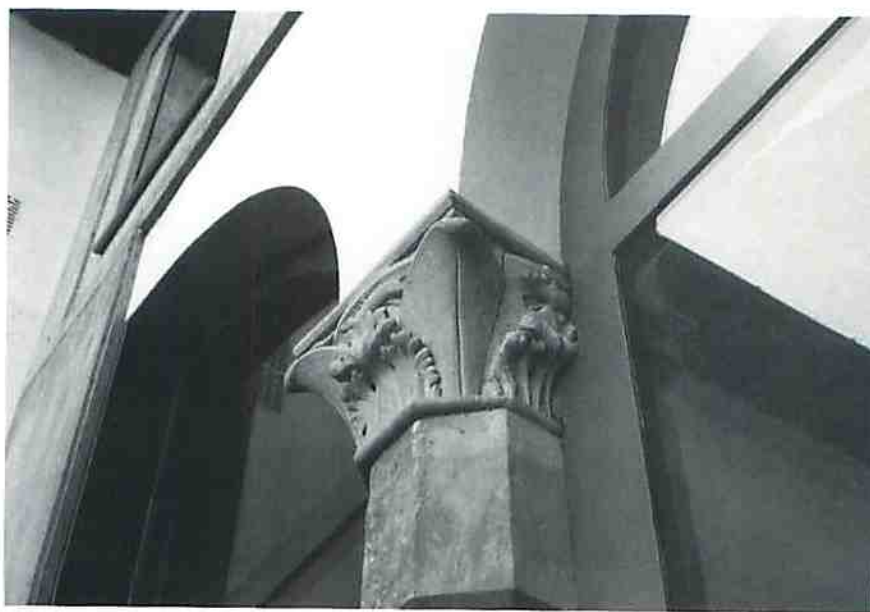
Particolare della 'facciata ricomposta' con il pilastro, il capitello, l'arco originale, la muratura in cemento armato.
